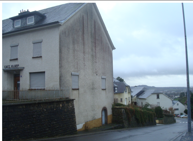
Photo 2 Rue Principale et façade latérale de l'ancien Café Klopp
