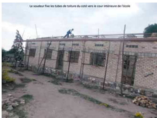
Le soudeur fixe les tubes de toiture du coté vers le cour intérieure de l'école
