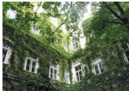
La végétalisation des façades et la présence d'arbres ralentissent l'écoulement superficiel de l'eau et ont un effet positif sur le climat. / Foto: Fassadenbegrünung und Bäume verbessern die Rückhaltung des Wasser und wirken zudem klimaregulierend
