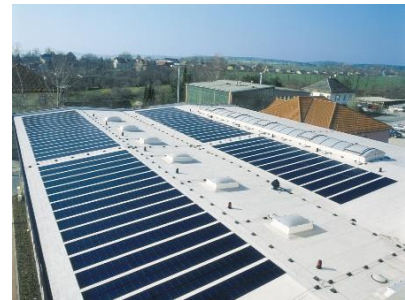
Abbildung 5: Photovoltaikanlage in Niederanven.
