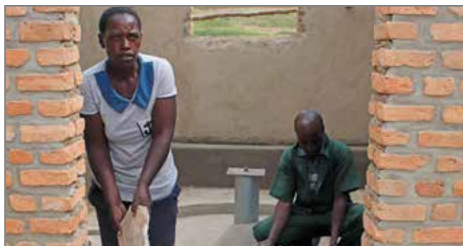
→ « Construction du bâtiment abritant le puits d'eau et la pompe permettant d'acheminer l'eau vers l'école de Nyundo »
